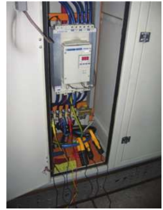
Мерење параметара електричне енергије у индустријском предузећу
