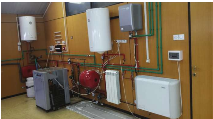
Развијене инсталације (а) Геотермална шойлошна џумџа са грејно-расхладним уређајима, (б) Инсталација за акумулацију шойлошне и електроенергије
