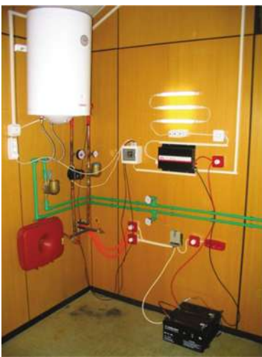
Развијене инсталације (а) Геотермална шойлошна џумџа са грејно-расхладним уређајима, (б) Инсталација за акумулацију шойлошне и електроенергије
