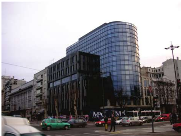
Примена композиционих панела шийа „Аликобонд“ и ламинираног стакла
